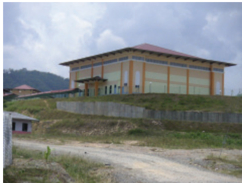
Gambar 4: Pembangunan Sekolah baru di Daerah Penampang
